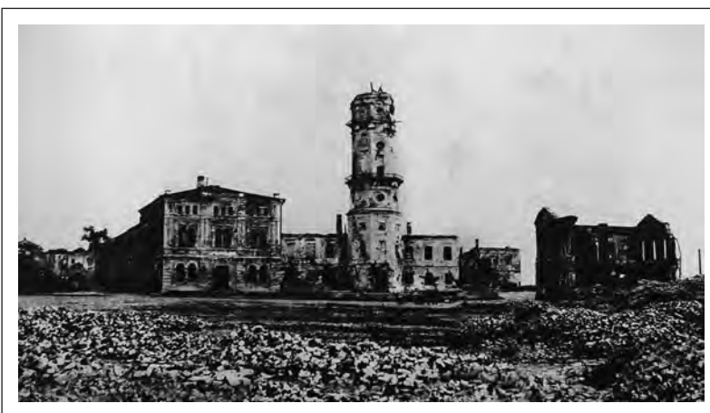
Разрушенная ратуша — пожарная каланча. Фото из фондов МОКМ
