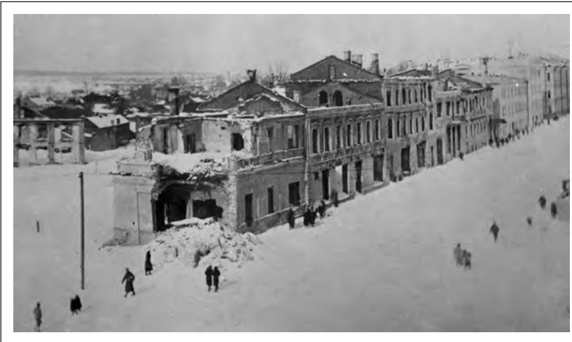
Разрушенные здания на ул. Первомайской. Район современного магазина «Могилевчанка». Фото 1945 г. из фондов МОКМ
